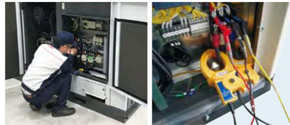
電力測定作業
