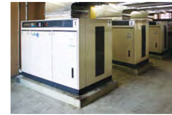
導入例: 製造工場にて SAS55SD 3台をマルチリンク式台数制御にて運用。
